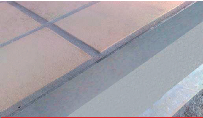
Esempio di posa paraspigolo terminale
